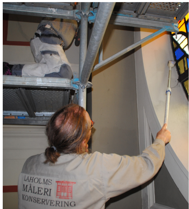
Lars-Ivar Nilsson från Laholms Målerikonservering håller på att rengöra väggen med en sotsvamp.
