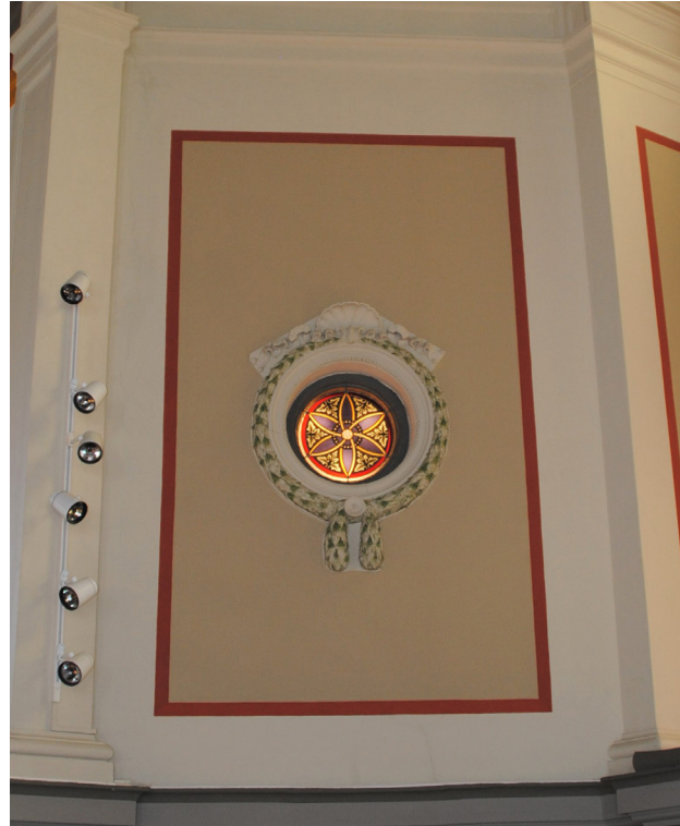
Till vänster och ovan: Väggytor på vänstra sidan om altaret efter rengöring och ommålning.
