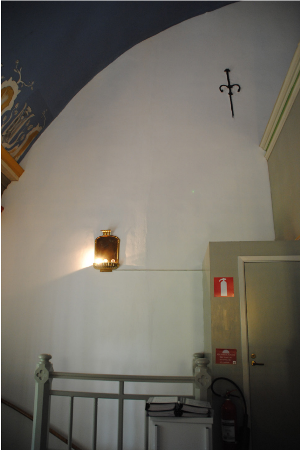
Ovan till vänster och ovan: De lodräta sprickorna på båda sidor om orgeln har reparerats. De har fyllts upp med glasfiberbruk och ytan har lagats med kalkbruk. Väggen har bättringsmålats med vit emulsionsfärg.
