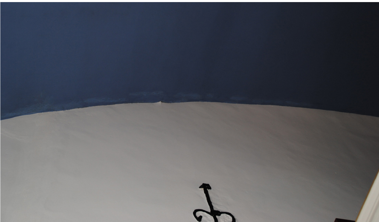
Sprickorna i taket längs med västväggen har rensats från löst bruk, lagats upp med kalkbruk och retuscherats med Flashe vinylfärg.
