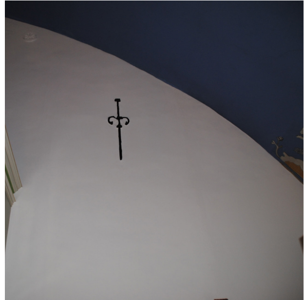
Ovan till vänster och ovan: De lodräta sprickorna på båda sidor om orgeln har reparerats. De har fyllts upp med glasfiberbruk och ytan har lagats med kalkbruk. Väggen har bättringsmålats med vit emulsionsfärg.
