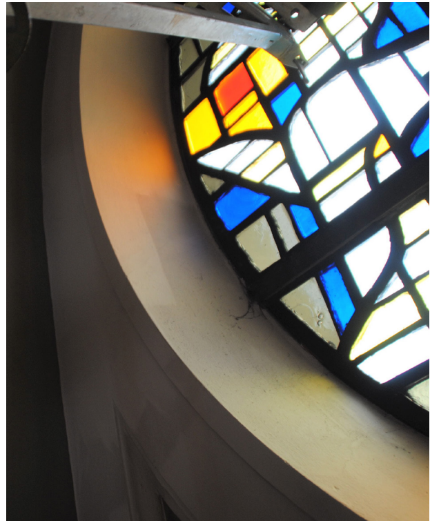
Korväggen var smutsad av sot och damm. Det blev en tydlig skillnad när den rengjordes.
